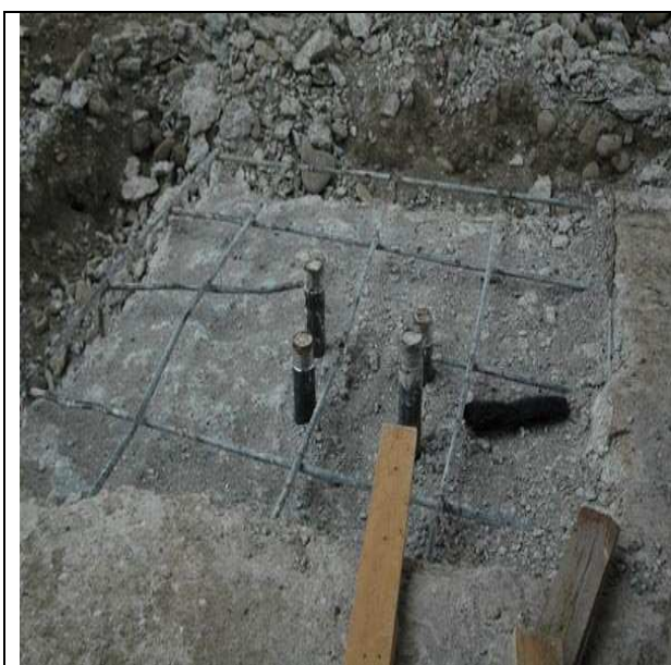
a) – Demolizione di un spigolo
